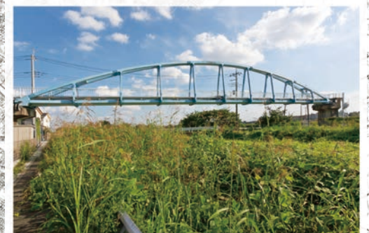
④ 姫宮水管橋
